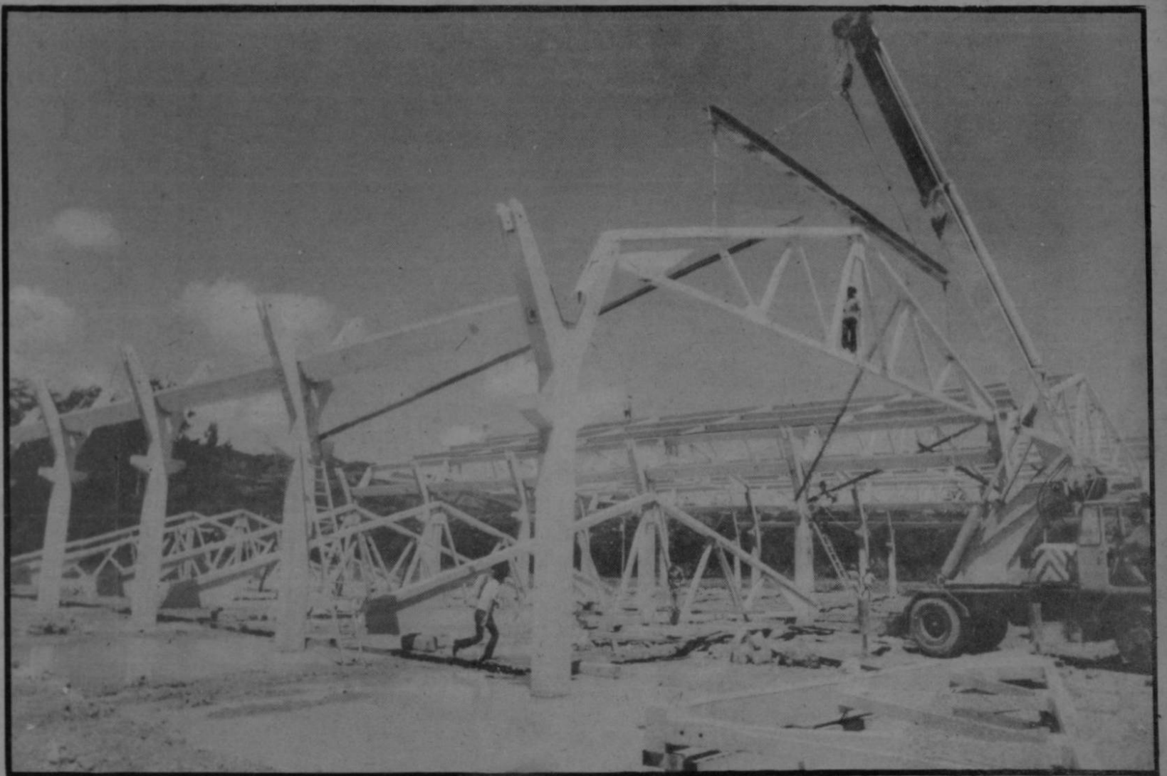
En la edificación de las naves industriales y de almacenamiento del Parque Industrial Cartago, se emplea una tecnología ampliamente experimentada en Europa, la cual permite edificar en plazos muy breves cualquier tipo de construcción.
