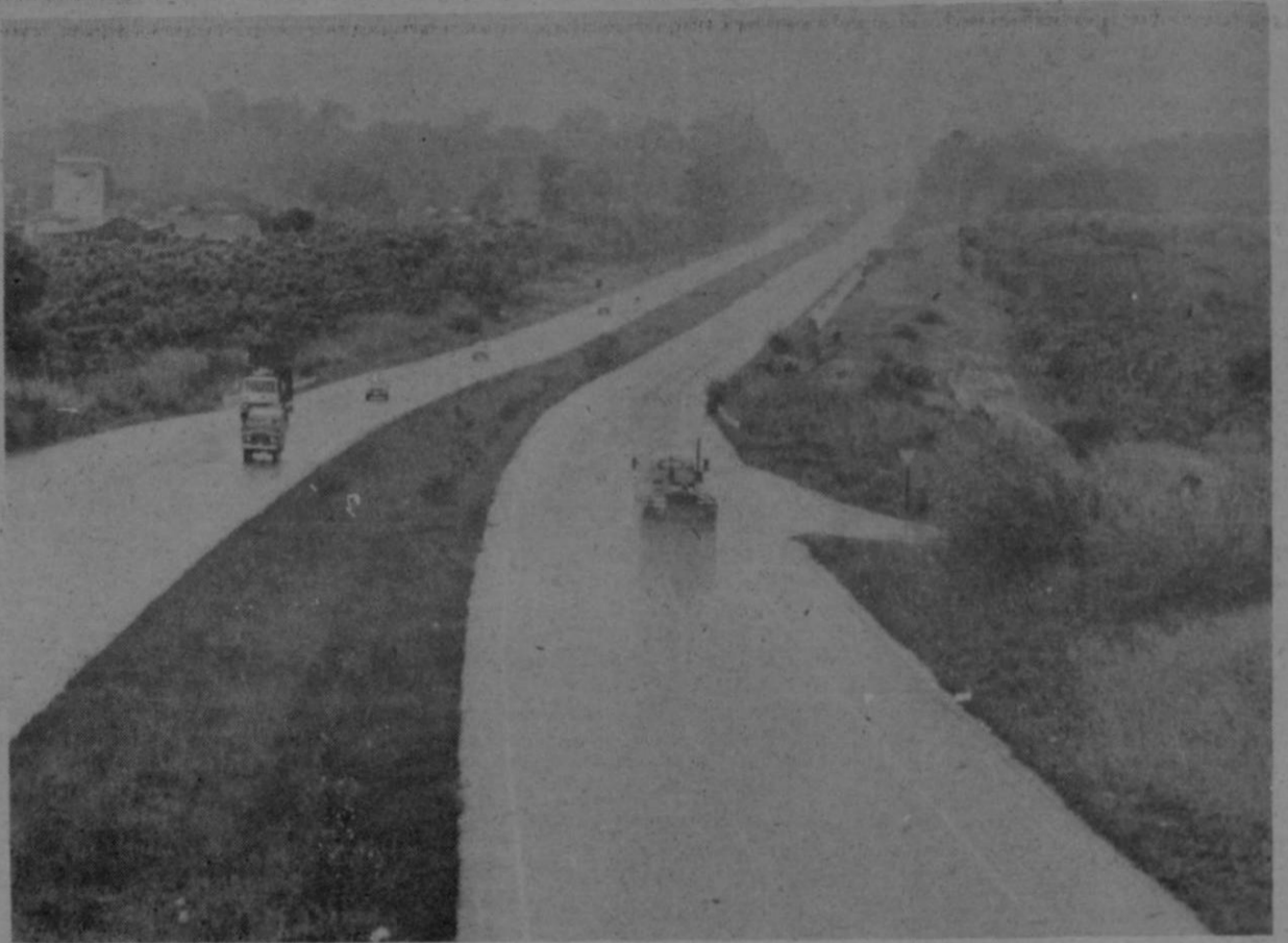
El Ministro de Transportes manifestó que durante 1981 no se paralizarán las obras de construcción de puentes y carreteras adjudicadas a varias empresas constructoras, que estuvieron a punto de paralizar 35 obras. Esta es la carretera Curridabat-Tres Ríos, totalmente terminada con aporte de $30.700.000 del Banco Centroamericano de Integración Económica. Sin embargo, otras carreteras que se construían tuvieron que ser paralizadas.
